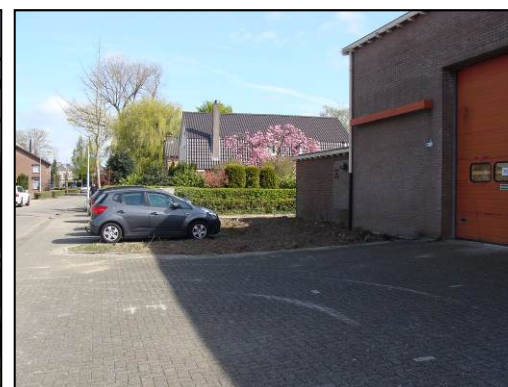
Foto 4. Voorzijde voormalige brandweerkazerne
