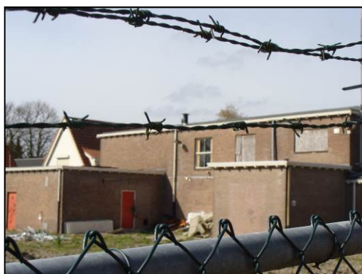
Foto 3. Achterzijde voormalige brandweerkazerne
