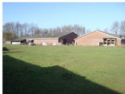
Foto 2. Te slopen gebouwen in noordelijke richting gezien.
