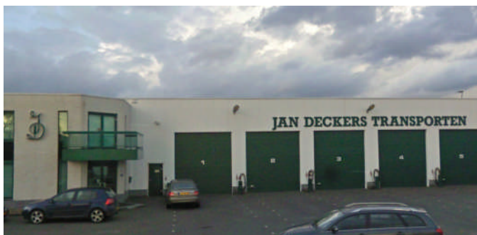
aansluiten bij bestaand bedrijfsgebouw
