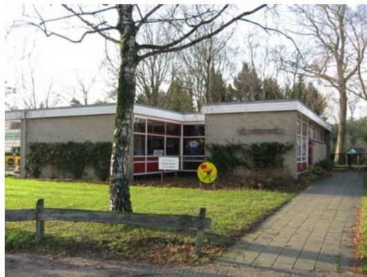
Schoolgebouw aan de Hulstweg
