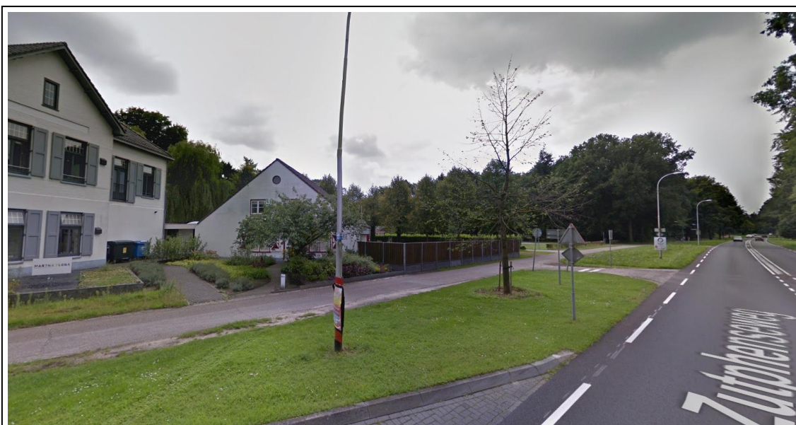
Figuur 6 – Situatie van het plangebied, gezien vanaf de Zutphenseweg (noordoosten), met op de voorgrond de belende bebouwing op het perceel Zutphenseweg 91 (bron: Google Streetview)
