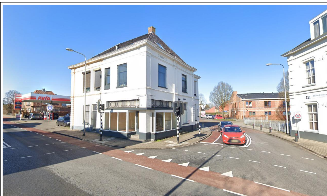
Figuur 5 – bestaande situatie vanuit het oosten (bron: Google Maps)
