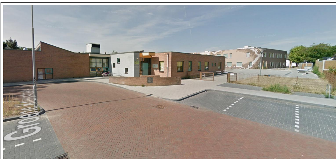
Figuur 7 – Het Groene Kruisstraatje gezien vanuit het noorden, met de bestaande bebouwing op het perceel Groene Kruisstraatje 4 (links en midden) en bebouwing van 'De Garve' (rechts op de achtergrond) (bron: Google Street View)
