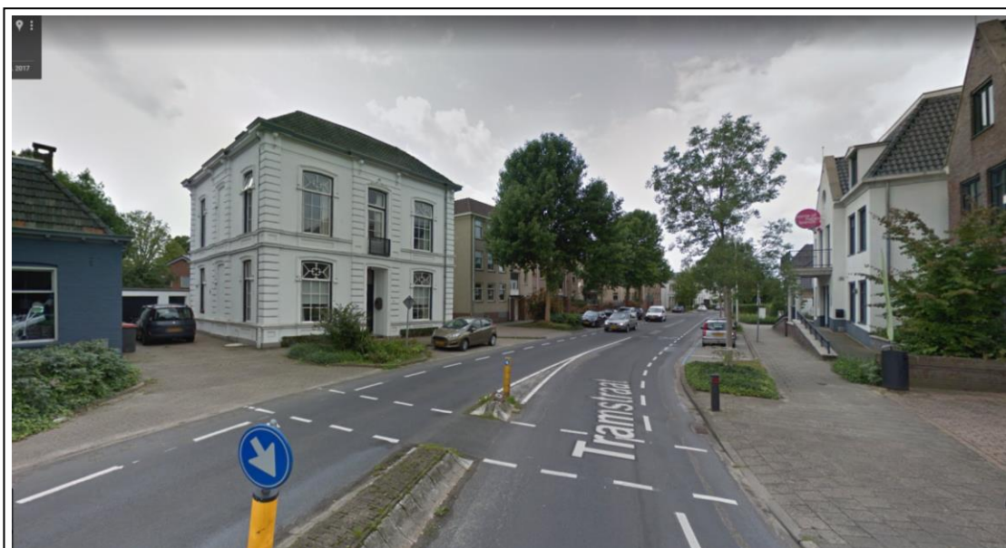
Figuur 4 – Huidig beeld van de Tramstraat, met nr. 13 links het witte woonhuis. (bron: Google Streetview)
