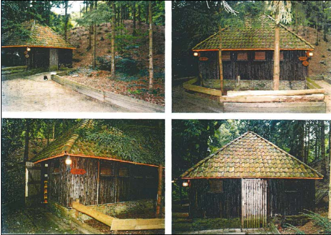
Huidige situatie toiletgebouw
