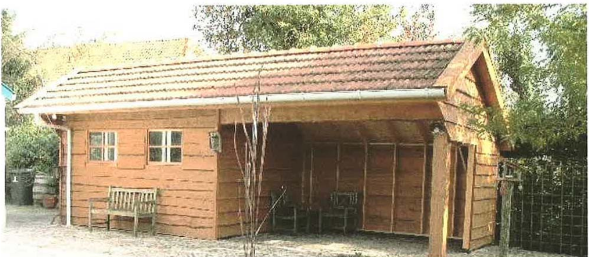
Gebouw B nieuw
