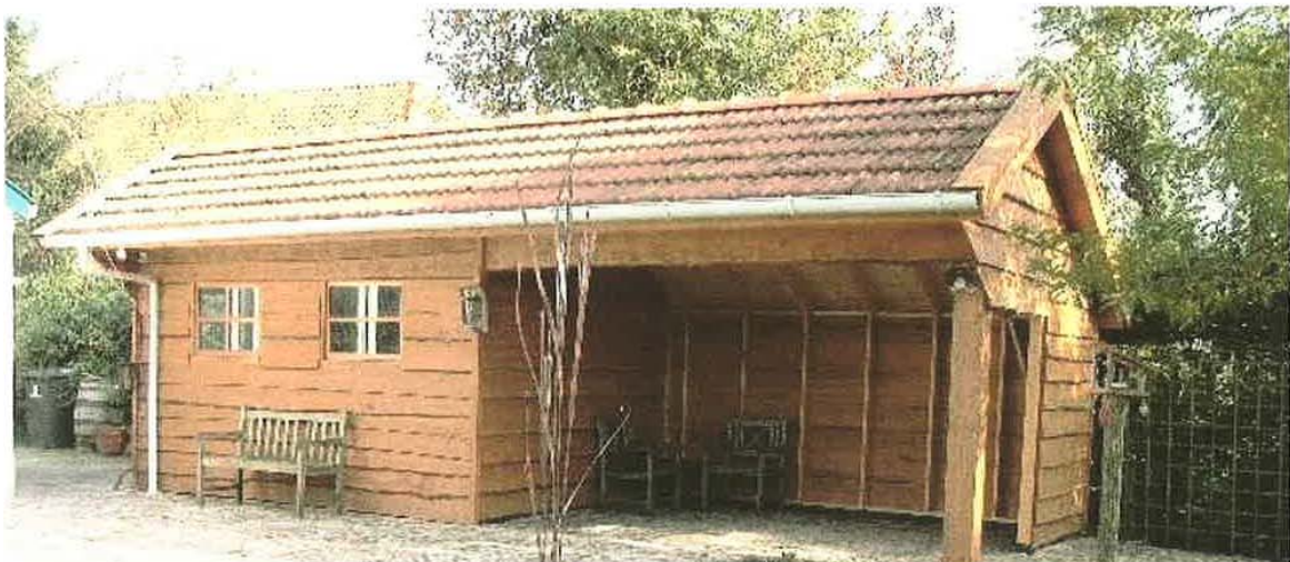
Nieuw gebouw B met zolder en pannendak
