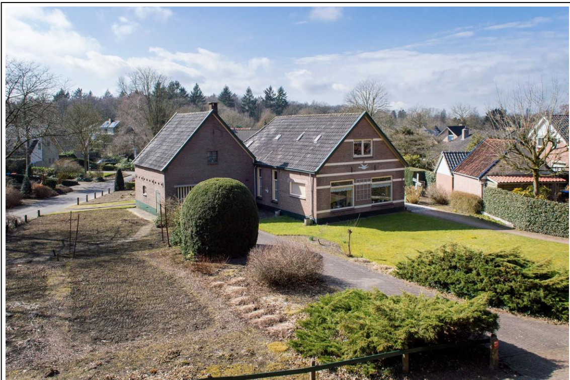
Figuur 4 – foto van de bestaande (en te slopen) woning (bron: Funda)
