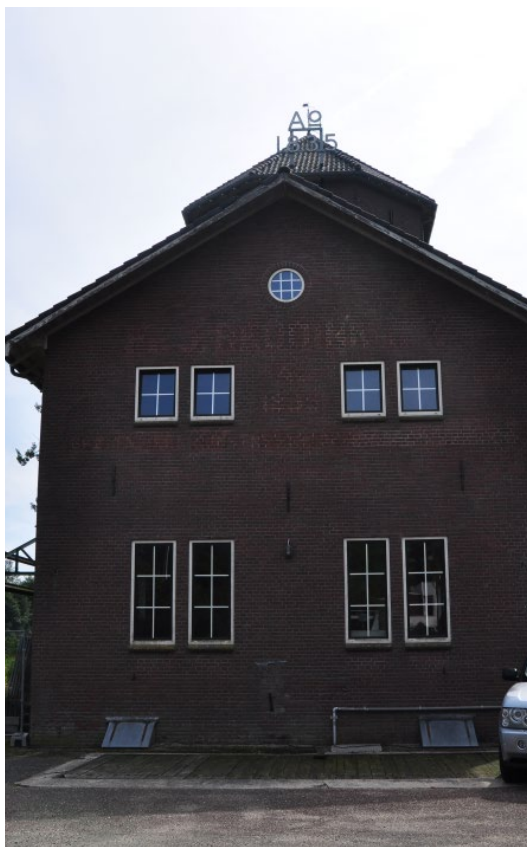
Foto overzicht van de oude silotoren
