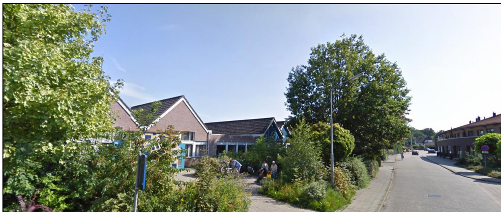
Het inmiddels gesloopte gebouw vanuit het noorden/burgermeester Leenstraat (bron: Street view)
