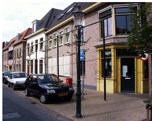
Nieuwbouw in het westelijk deel Achterstraat
