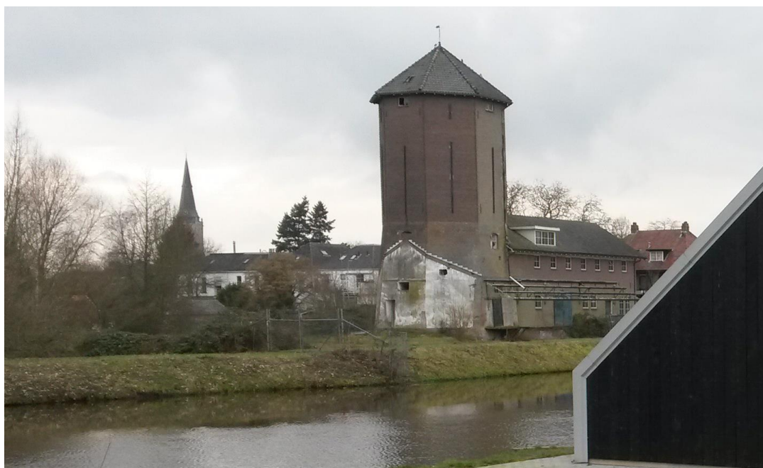
Figuur 10 – Bestaande bebouwing binnen het plangebied, waarvan het zuidelijk deel als silotoren in gebruik was, gezien vanaf het terrein Stijgoord (ter hoogte van de Zompenloods)
