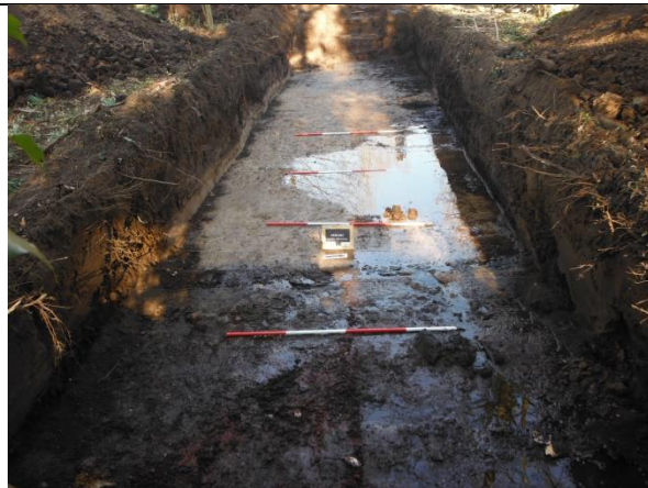
Vlak werkput 6 met op voorgrond demping in deel watergang
