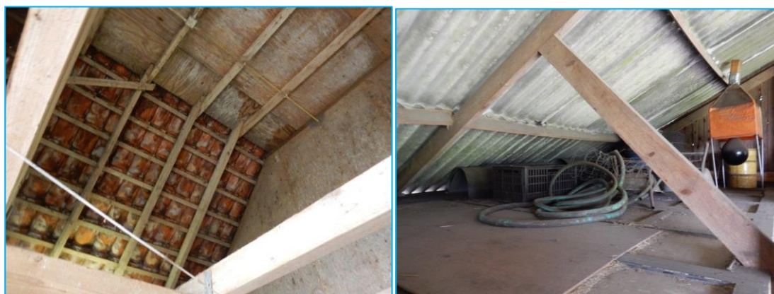
Foto: Indrukken plangebied. Paardenstal en kapschuur.
