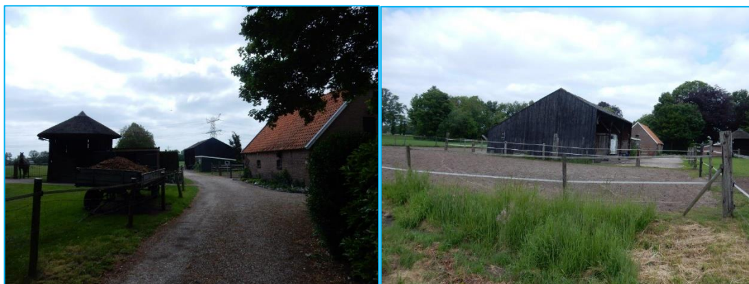
Foto: Indrukken plangebied. Paardenstal en kapschuur.
