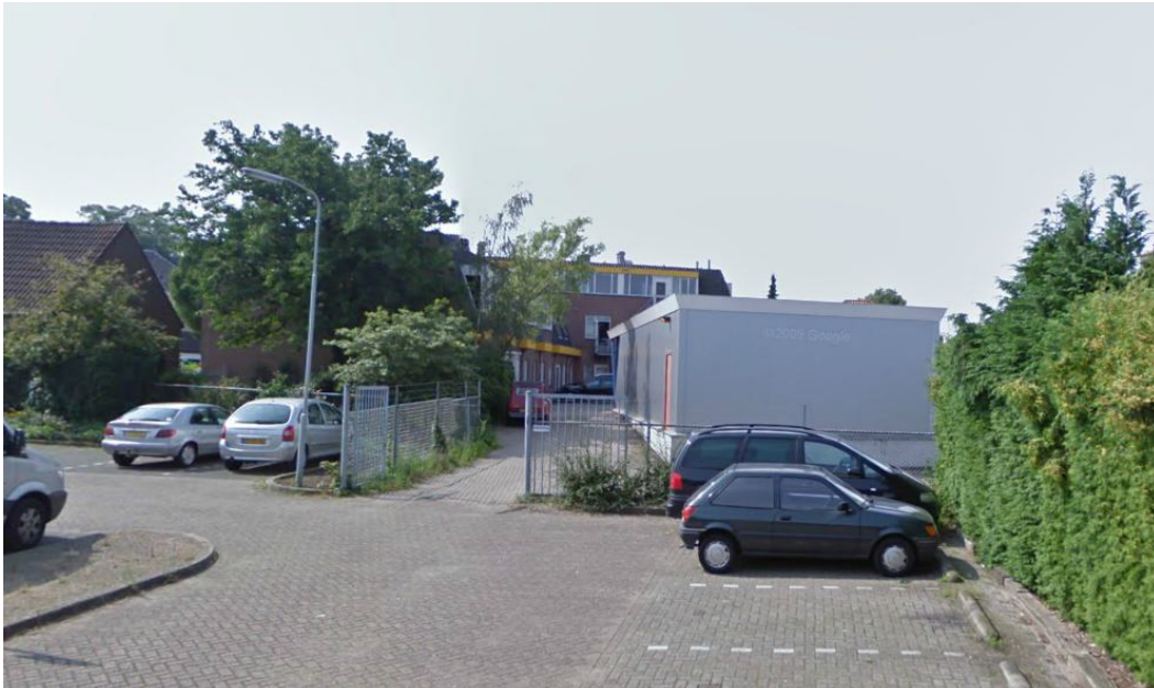
Achterzijde bestaand kantoorgebouw en bijgebouw op het perceel Albert Hahnweg 2 (bron Google Streetview)
