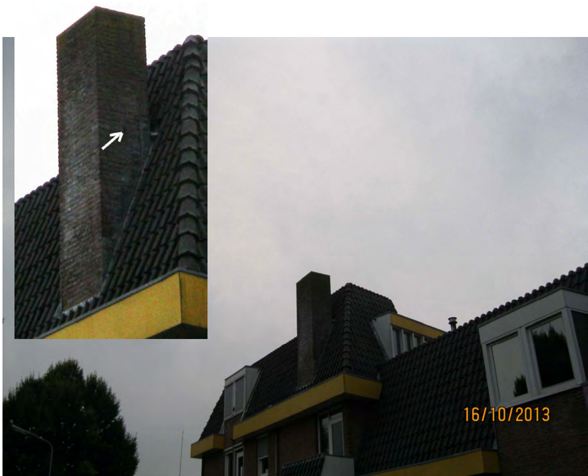
schoorsteen met opening naar de spouw
