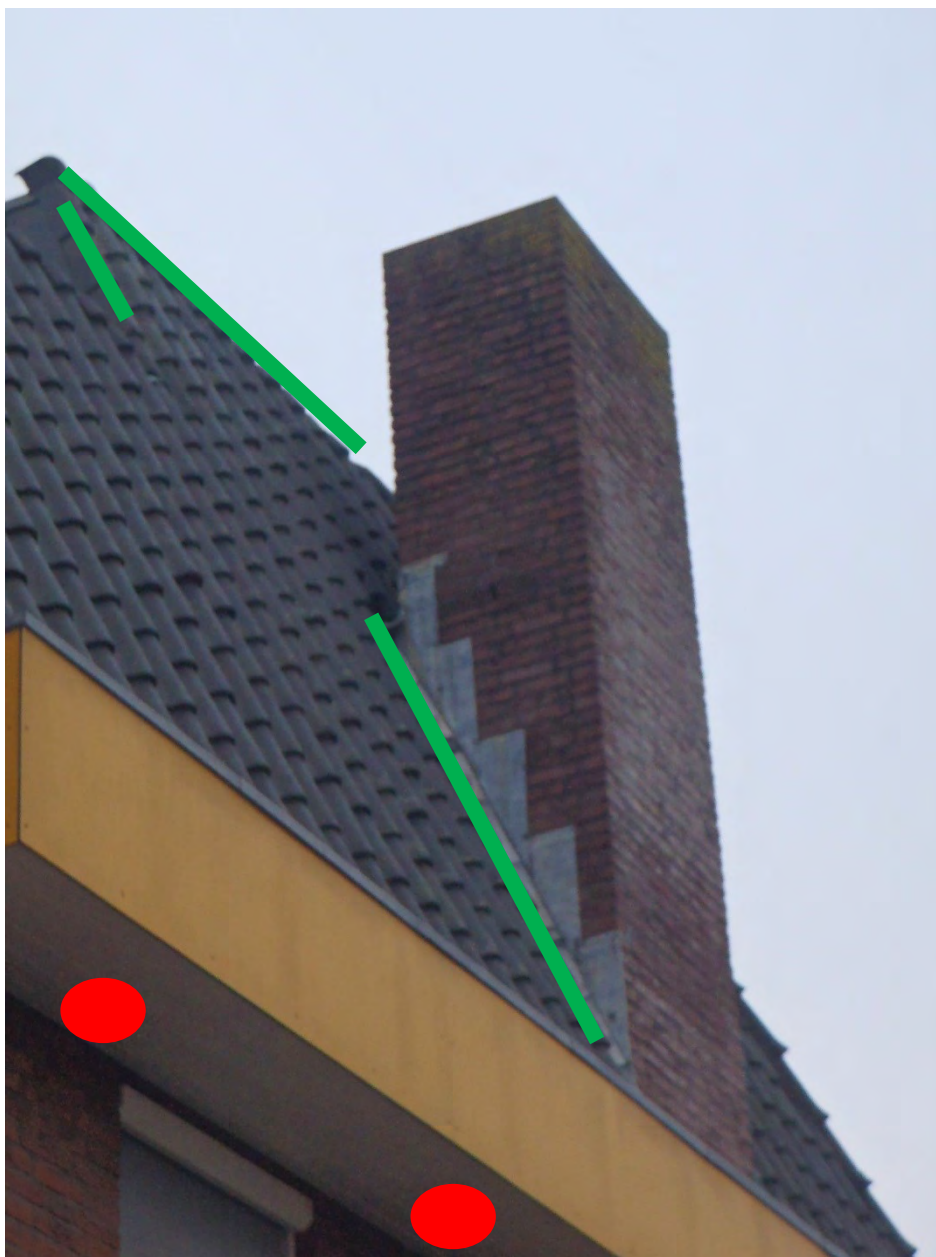
Foto 3: loodslabben naast de schoorsteen, deze worden omhoog gezet. Dn de eerste rij pannen naast de schoorsteen aan de bovenzijde nok en kantpannen worden gaten gemaakt groene lijnen (indicatief). In de betimmering zijn aan de onderzijde weer gaten gemaakt, rood (indicatief).
