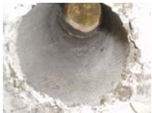
(2) AC buis, ontluuchtingsbuizen (ca. 8x a ca. 0,5m1 dsn 120, zichtbaar)
