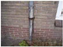
(6) AC buis, hemelwaterafvoer (5x a ca. 1,5m1 zichtbaar, dsn80)
