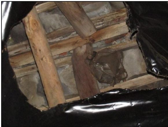
Figuur 12. Dakbedekking van het deel van de oostelijke bebouwing is ongeschikt voor vleermuizen.
