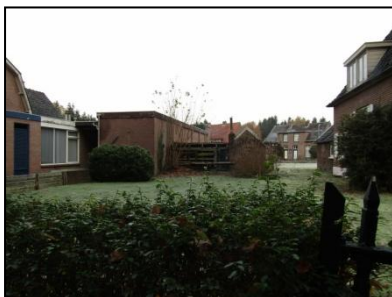
Figuur 6. Het tussenliggende stenen schuurtje en gedeelte van de grote schuur.
