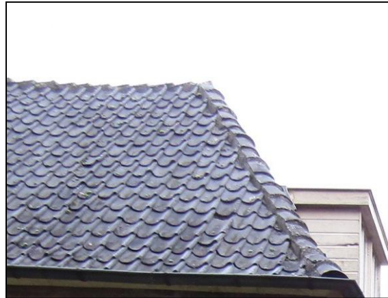
Figuur 11. Dichtgemetselde nokpannen.
