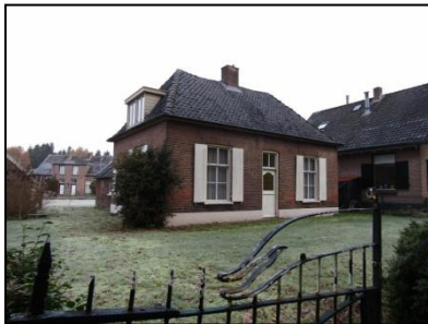
Figuur 3. Het oostelijk gelegen woonhuis, nummer 16.
