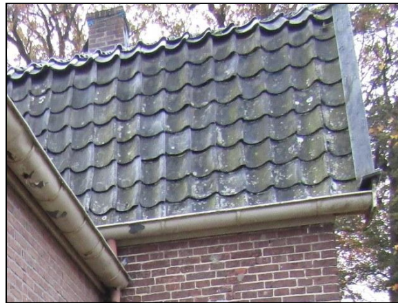
Figuur 13. Dakpannen op de westelijk bebouwing bieden geschikte verblijfplaatsen.
