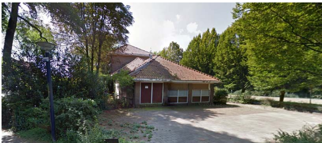
Voormalig schoolgebouw op de locatie Kompas aan de noordzijde van het plangebied
