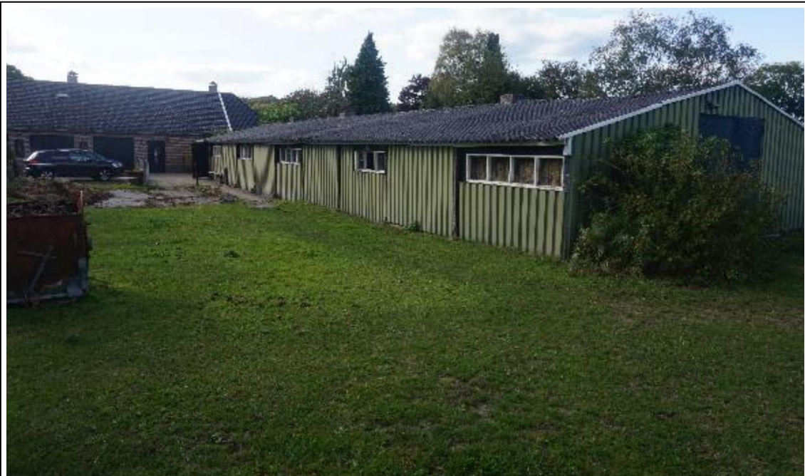
Figuur 8 – foto van het meest noordelijke voormalige bedrijfsgebouw (bron: EcoReest)
