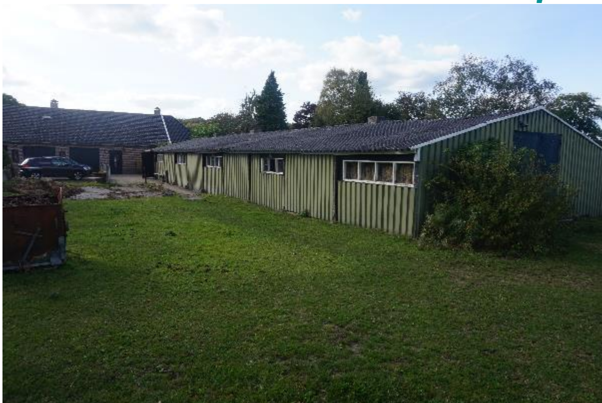
Figuur 2.4. Zuidoostkant van de schuur.
