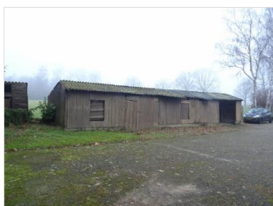
Figuur 2.9 Houten schuur aan de westzijde van de onderzoekslocatie.
