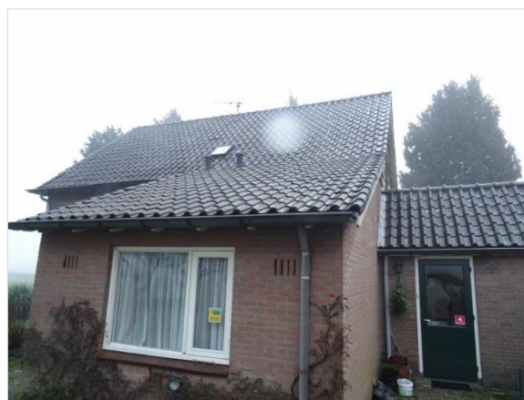
Figuur 5.1 Ruimte onder de eerste rij dakpannen.
