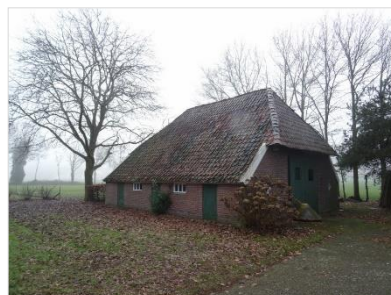
Figuur 2.5 Schuur aan de zuidzijde van de onderzoekslocatie.
