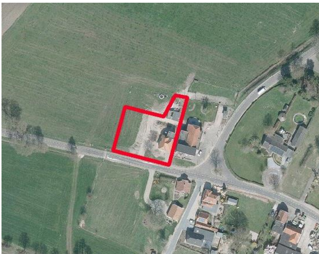
Luchtfoto huidige situatie perceel Zwiepseweg 145 (bron: provincie Gelderland)
