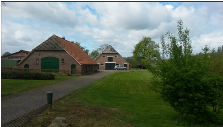
Bestaande boerderijwoning achterop het perceel
