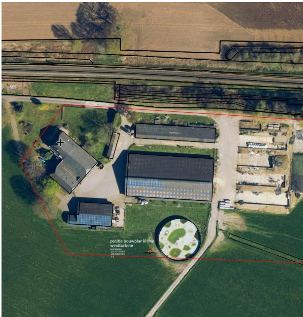
Figuur 3. Luchtfoto beoogde locatie bouwplan kleine windturbine (rode stip) binnen het agrarisch bouwperceel volgens het bestemmingsplan (rode lijn).
