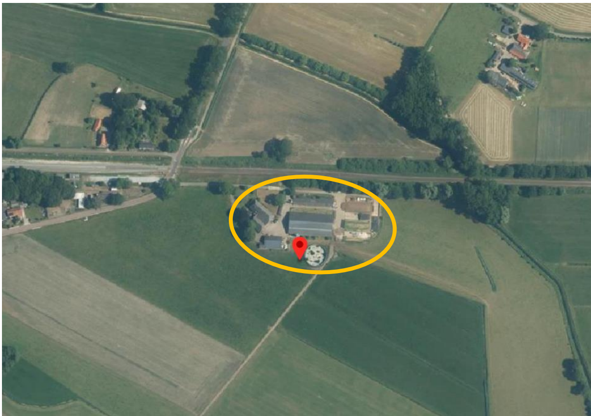
Figuur 1: Luchtfoto perceel Zutphenseweg 53 Laren met in rood de indicatieve locatie van de kleine windturbine.
