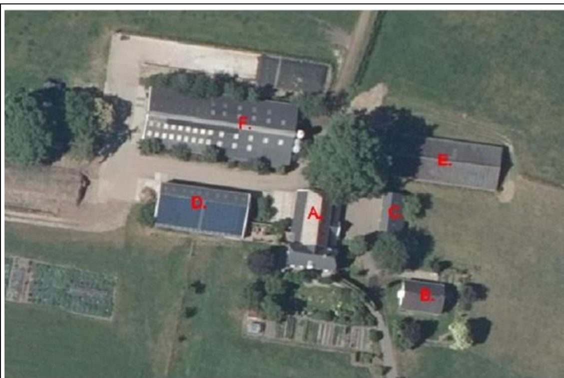
Figuur 6 – Overzicht bestaande gebouwen in het plangebied (Bron: Landschapsplan Zutphenseweg 52 Laren)
