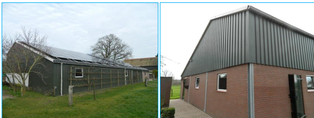
Foto's: Indrukken plangebied. Opstal 4, loods.
