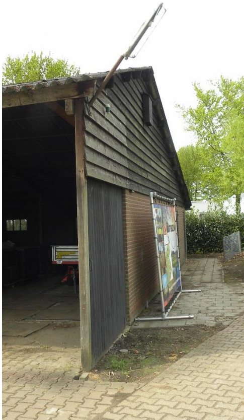
Voorbeeld van een vleermuis kraamkast tegen een kapschuur
