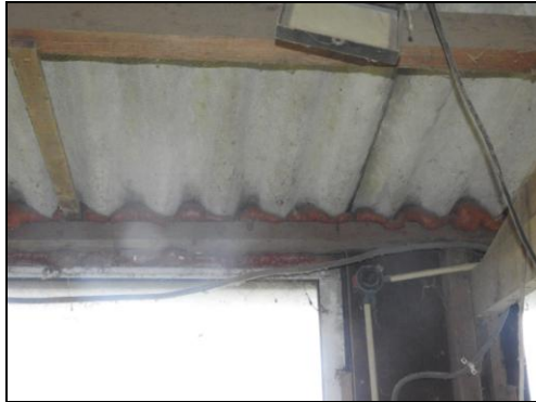
Afbeelding 3: dak en buitenmuur
