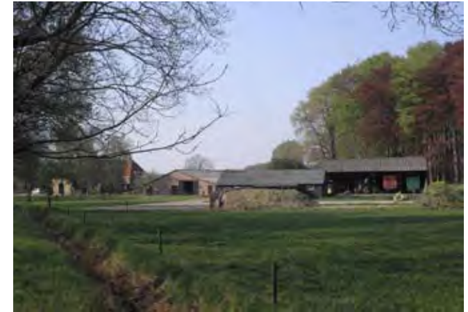
Zicht op te slopen bebouwing vanaf de Lage Lochemseweg
