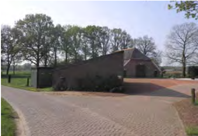
Te slopen bijgebouw dat momenteel zicht op het erf (gedeeltelijk) belemmert
