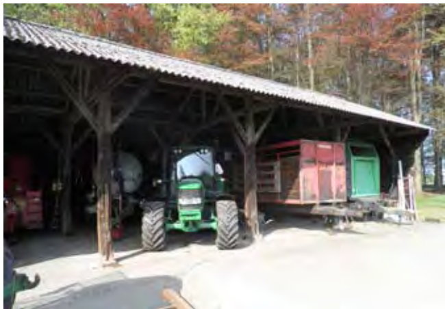
Werktuigenloods met oude houten kern en gebinten wordt gedemonteerd en herbouwd als bijgebouw van boerderij ten behoeve van opslag machines en materialen (zie hoofdstuk 6)
