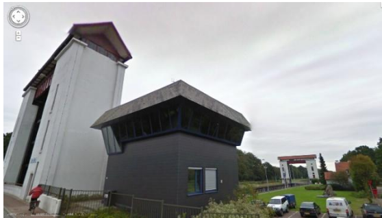
1-3: De Sluis, sluiswachterhuis en woning.
