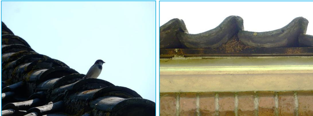
Foto's: Waargenomen huismus en nestmateriaal onder de dakpannen.
