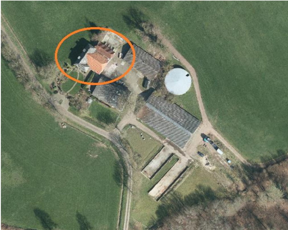
Figuur 1: Luchtfoto perceel Schuppert 11 Barchem. In de oranje cirkel de te verbouwen woonboerderij.
