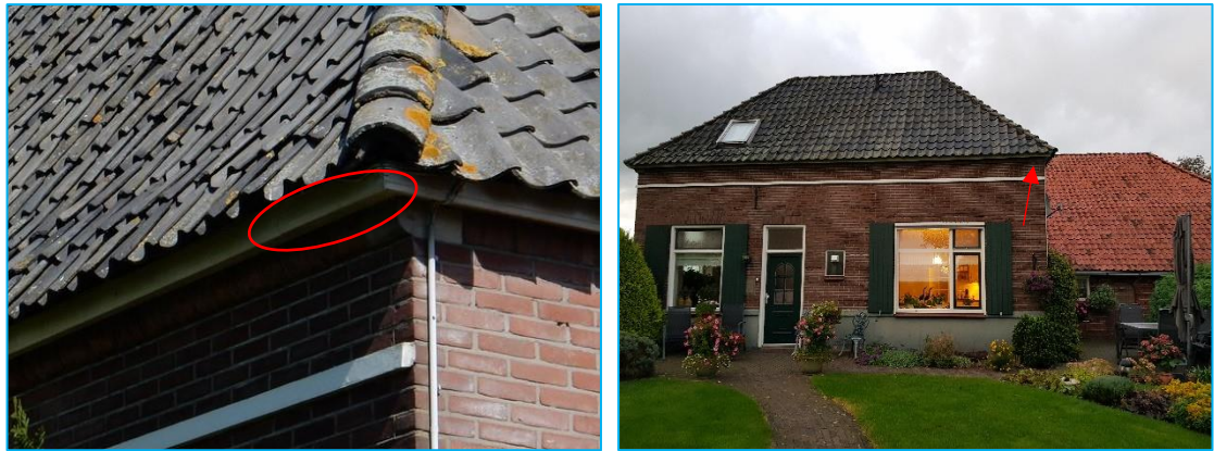
Foto's: Uitvliegplek paarverblijf gewone dwergvleermuis ter plaatse van opstal 1.
