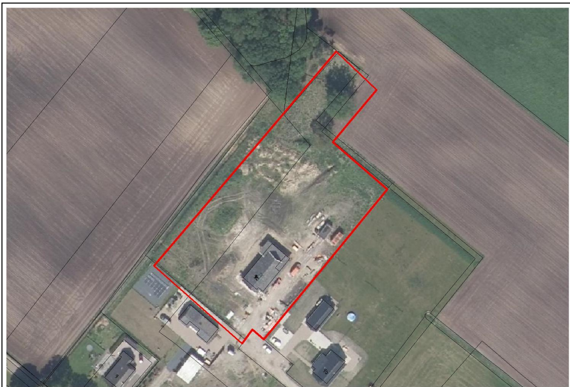
Figuur 3 – luchtfoto bestaand erf Schepersweg 9c te Harfsen
