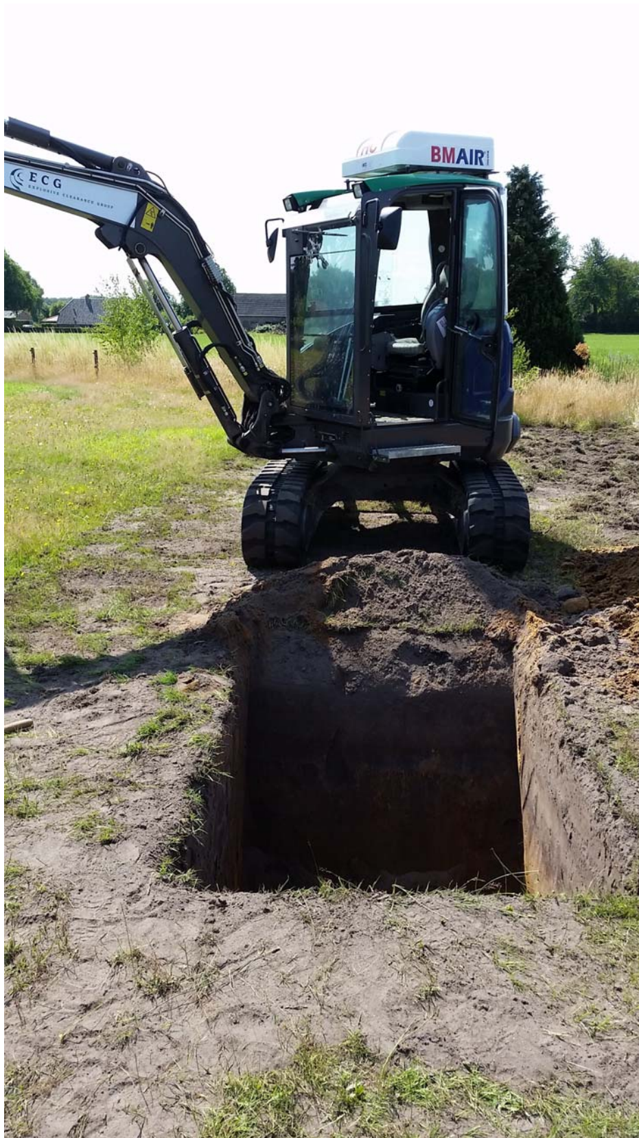
Figuur 17: Het uitgraven van de proefput
