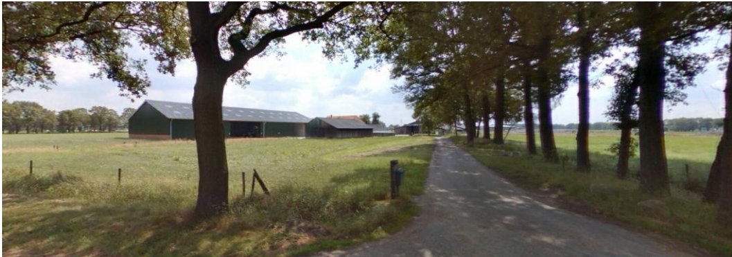
Aanzicht R wlerdijk 2, vanaf de toegangsweg
