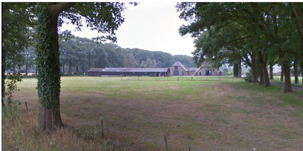
Het perceel Rossweg 6 gezien vanaf de gelijknamige weg (bron: Google Streetview)
