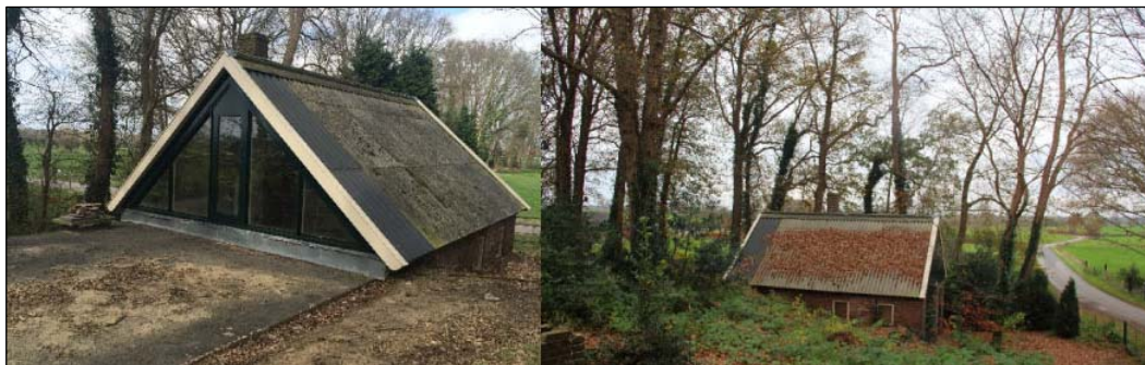
Bestaande schuur die voor ongeveer de helft in de zandrug ligt
