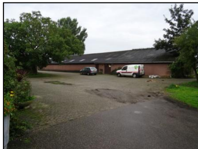
Figuur 4. Te slopen veestal.
