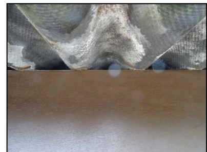
Figuur 7. Potentiële verblijfplaatsen vleermuizen.
