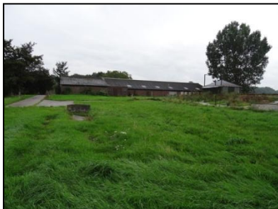
Figuur 3. Weiland met op de achtergrond de te slopen veestal.
