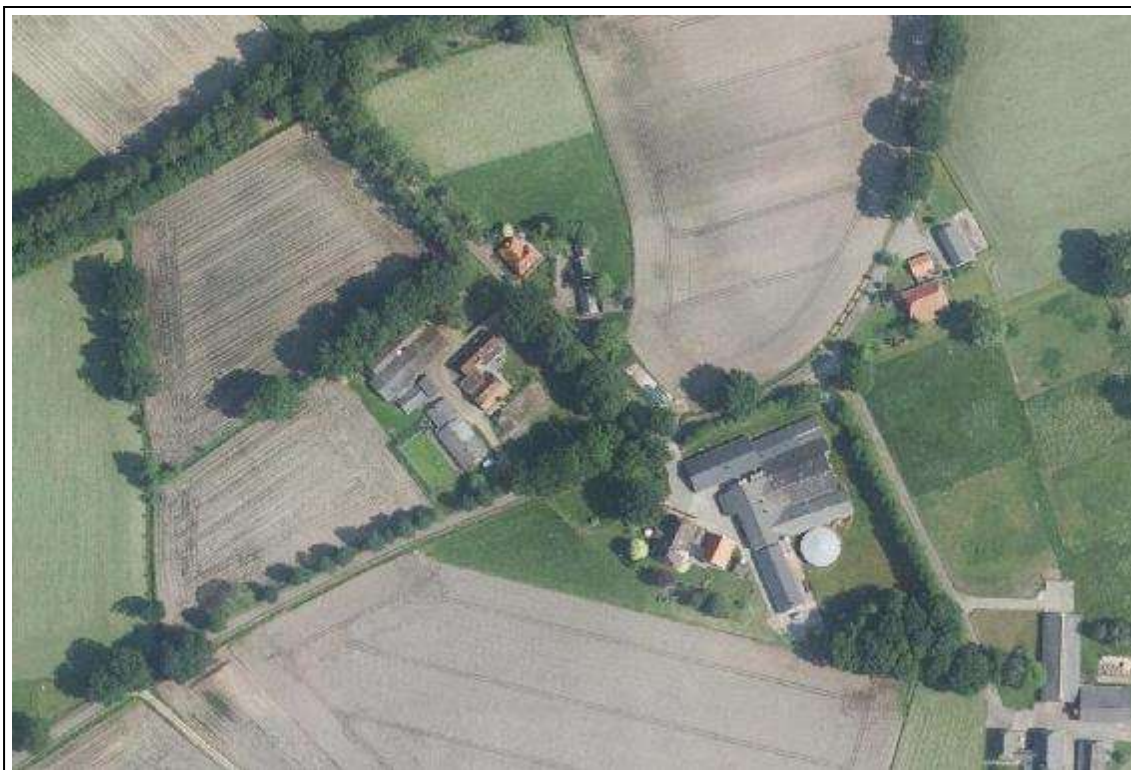
Figuur 3 – Luchtfoto erf Pekkeriet 3
