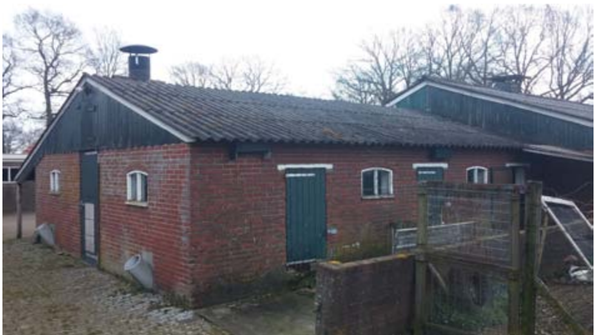
Voormalige, kleine varkensschuur (D). Wordt gesloopt.
