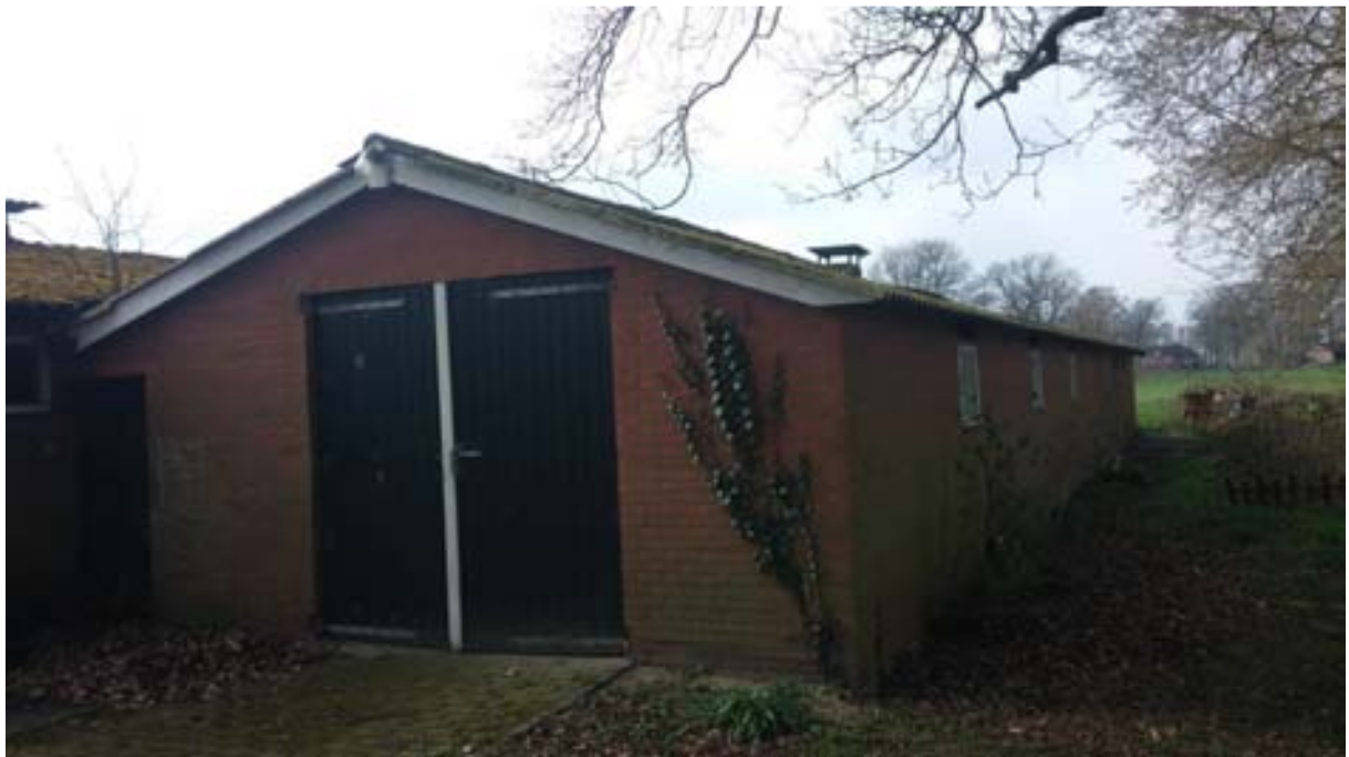
Kleine varkensschuur (H), wordt gesloopt.
