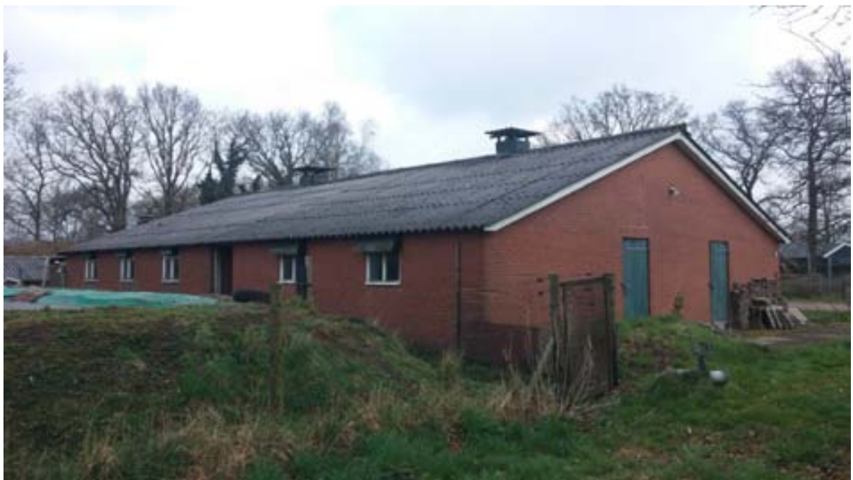
Voormalige varkensschuur (C), wordt gesloopt.
