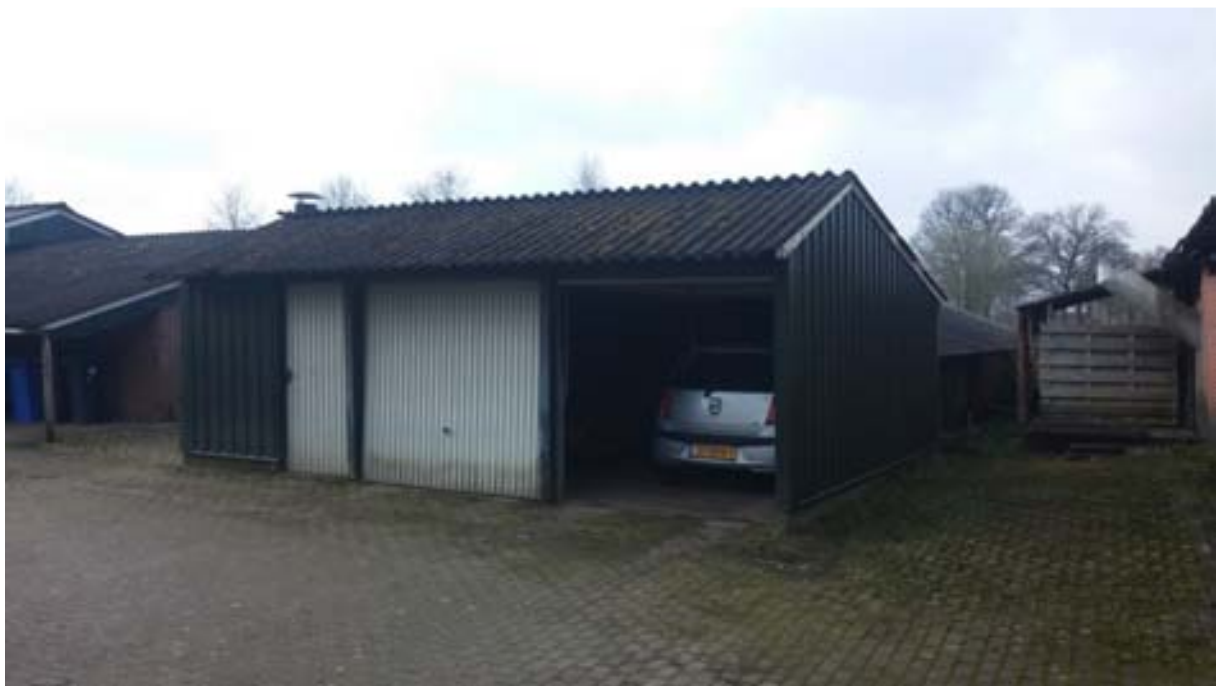
Garage (E), wordt gesloopt.
