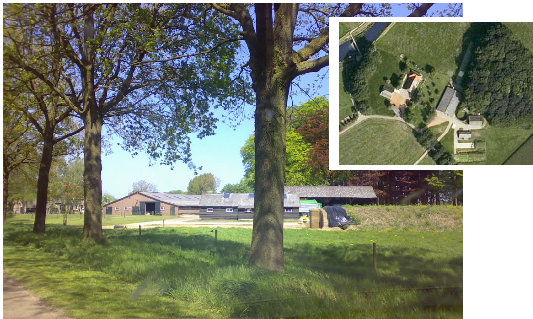
Afbeelding 4: Agrarische bebouwing plangebied, vanaf de zuidzijde Lage Lochemseweg
