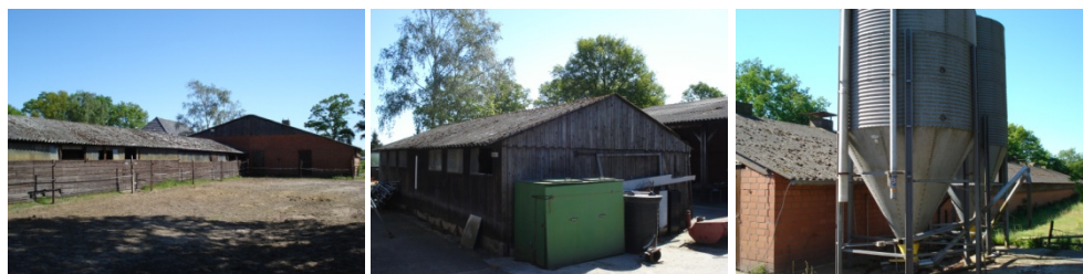
Foto's: De te slopen opstallen.
