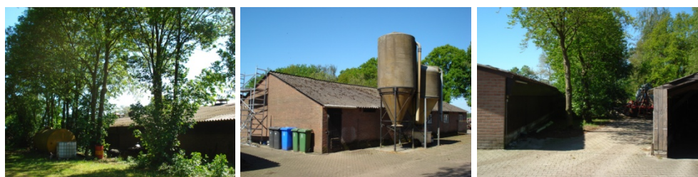
Foto's: De te slopen opstallen.
