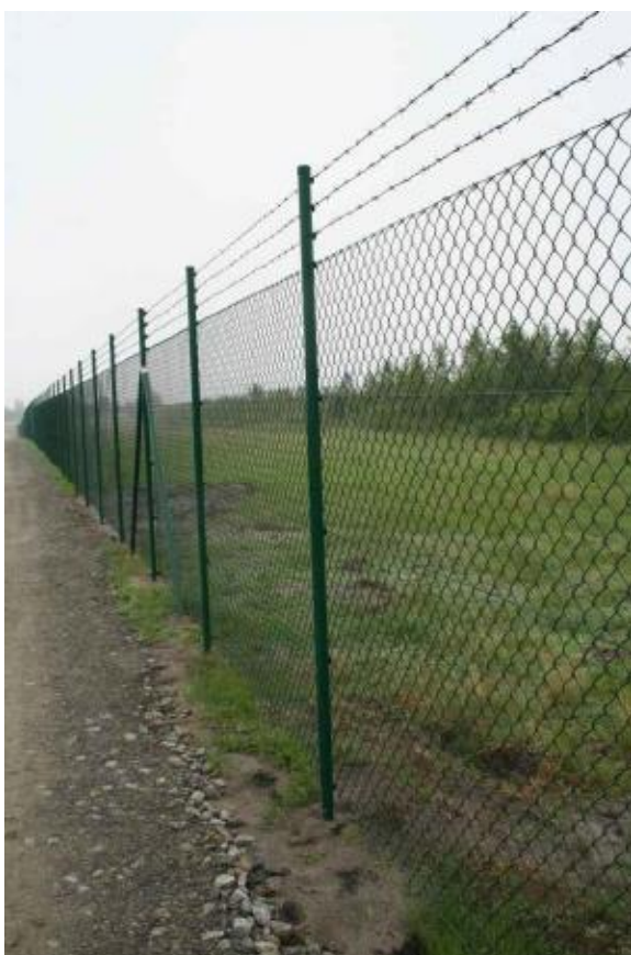
Figuur 7: impressie toe te passen hekwerk
