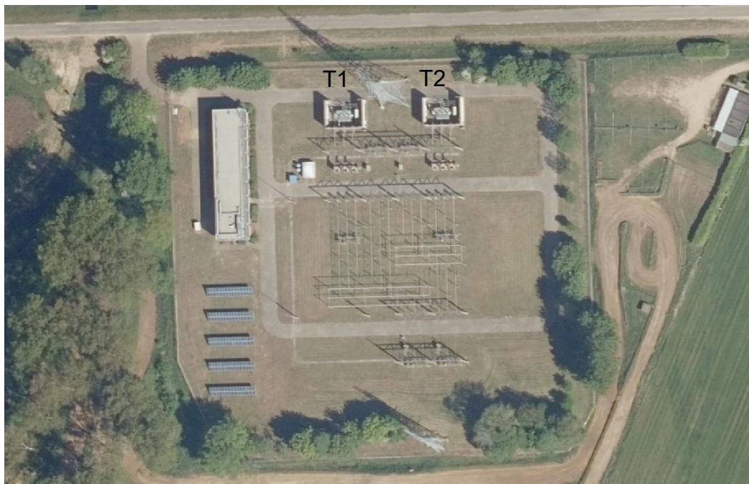
f2.2 Overzicht transformatoren huidige situatie
