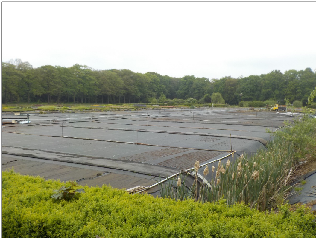
Afbeelding 13: Overzicht van het noordoostelijke gelegen kweekveld (foto in noordoostelijke richting)
