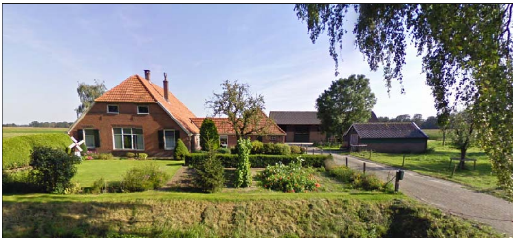
Figuur 5: Vooraanzicht van het plangebied, gezien vanaf de Horstweg (bron: Google Streetview)
